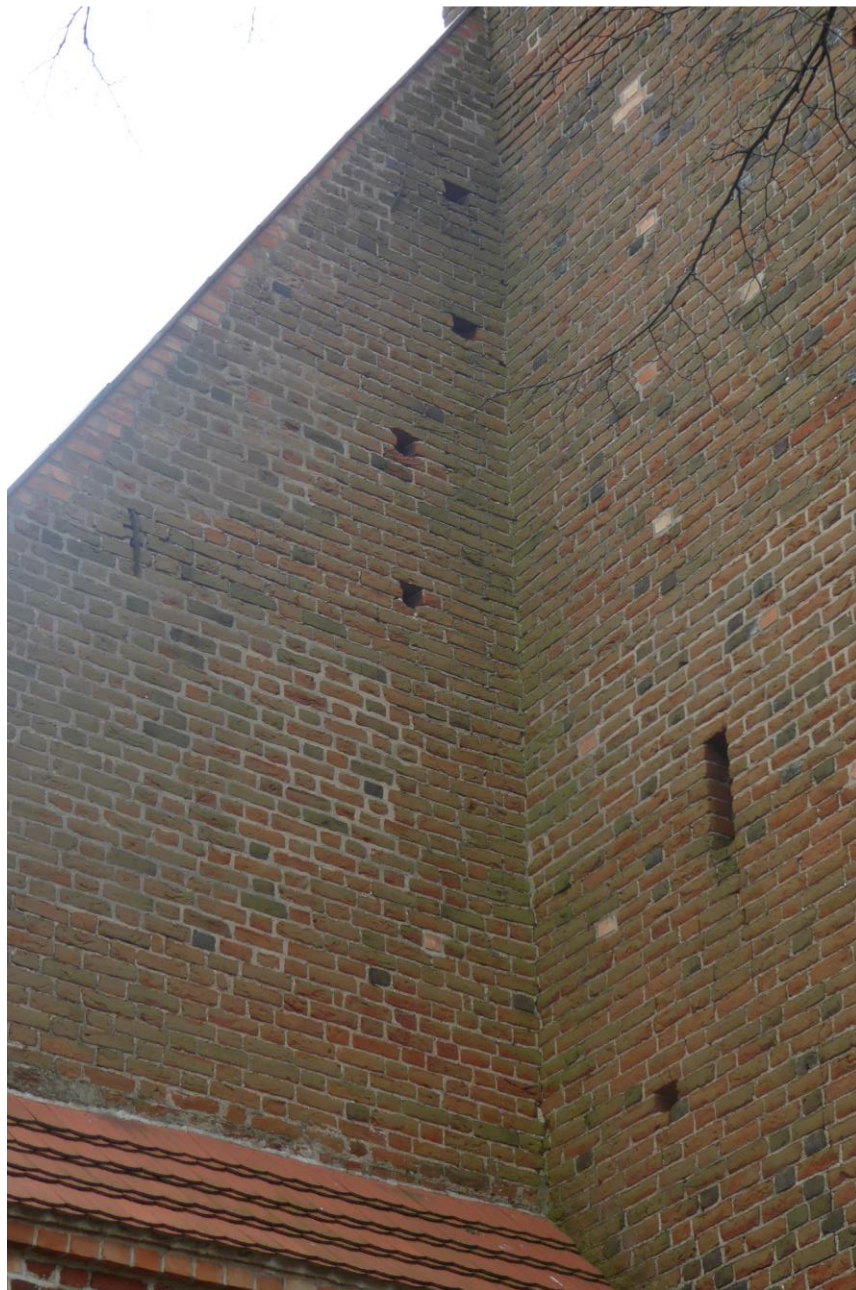
Fot.13. Nawarstwiania organiczne – glony na PN elewacji
