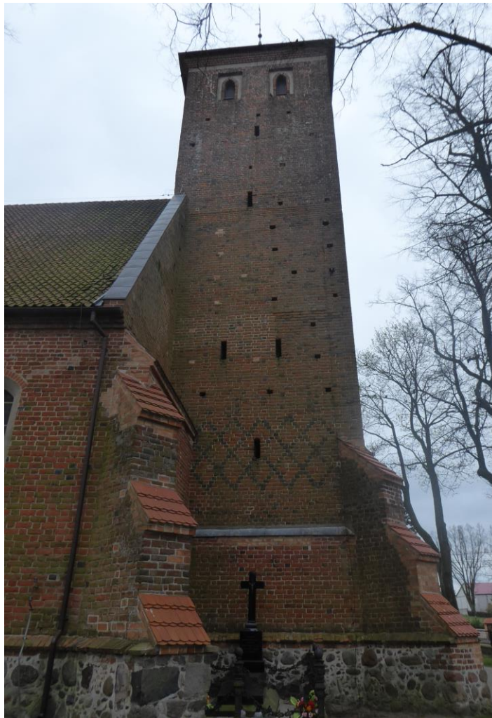
Fot.5. Elewacja północna - wieża
