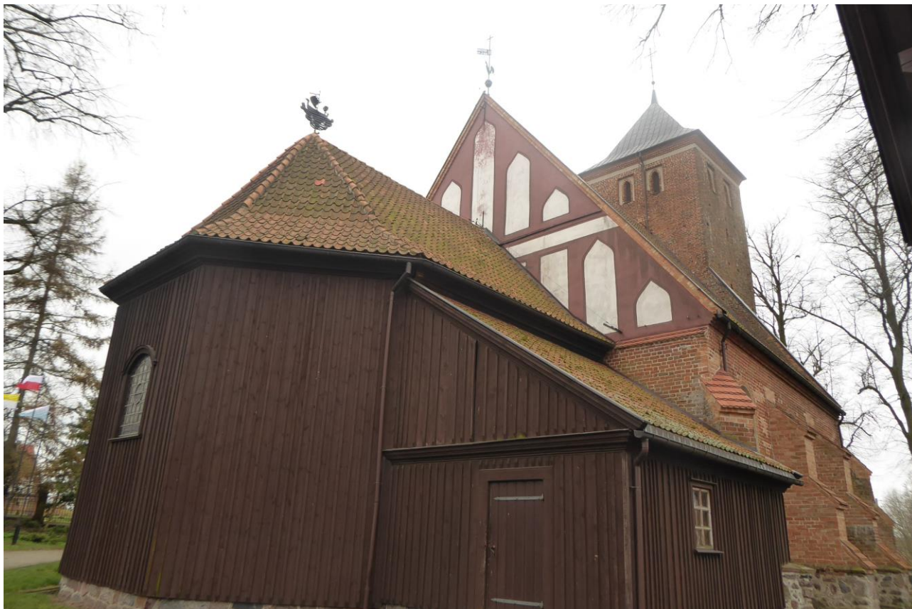
Fot.3. Elewacja wschodnia
