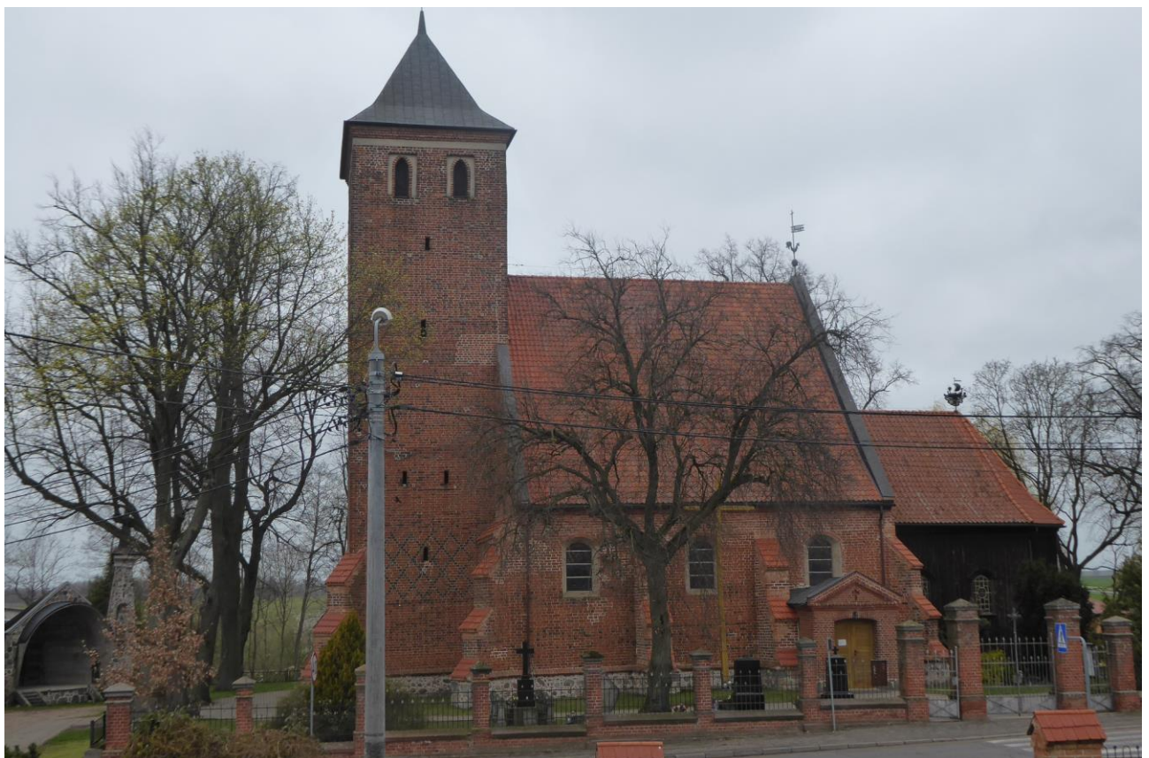
Fot.2. Elewacja południowa
